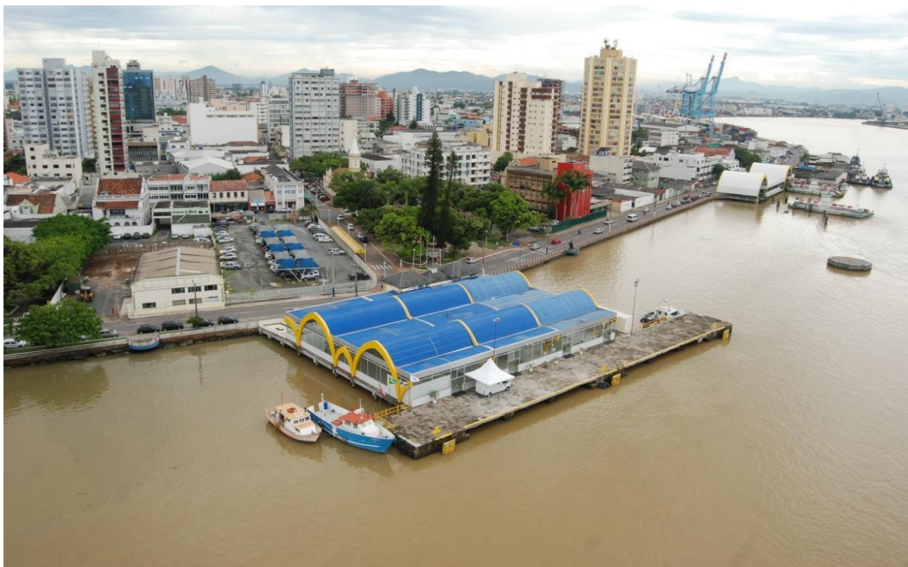
Figura 10 – Vista aérea do Terminal de Passageiros do Porto Organizado de Itajaí.
